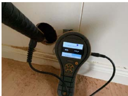
Hulltaking - Fuktmåling - Tørr konstruksjon i hulltakingsområdet.
