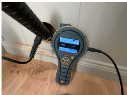
Hulltaking - Fuktmåling - Tørr konstruksjon i hulltakingsområdet.
