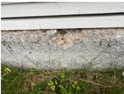
Noe flassing av mur.
