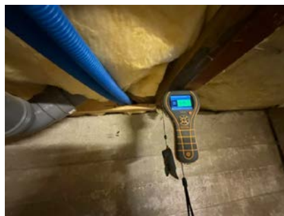
Fuktmåling i bjelkelag rundt sluket.
