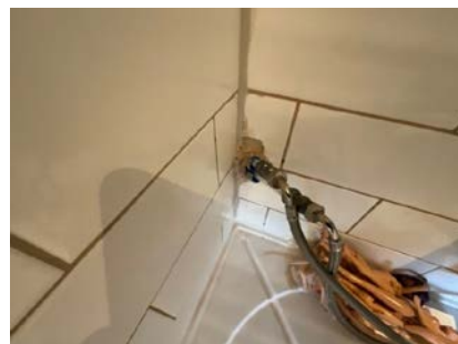
Vannrør i dusjsonen.
