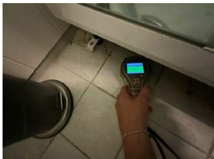
Fuktsøk under dusjkabinett.
