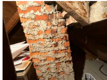
Mursteinspipe på kaldloft.
